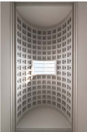
Die renovierte Decke im Theseustempel 2015
