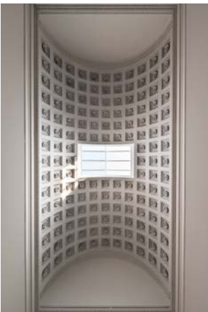
Die renovierte Decke im Theseustempel
